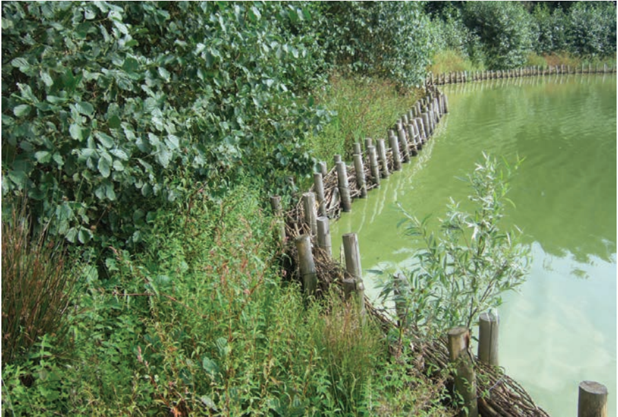
Kunstmatige oeververdediging beschermt de oever en doet dienst als paai- en broedplaats voor vissen en amfibieën.
